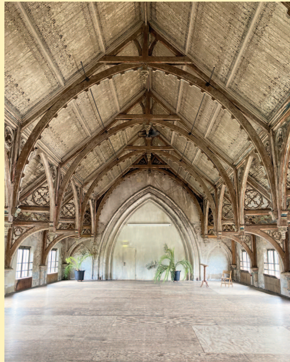
De kapconstructie van de Metaalkathedraal in De Meern, gemeente Utrecht. (Foto: Gelders Genootschap)
